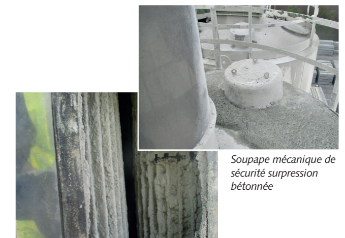
Exemple d'un filtre bouché
