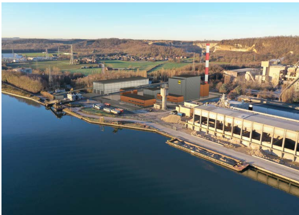
De installaties van CBR Lixhe zullen aangedreven worden door biomassa, geproduceerd door Bee Green Wallonia. ©BSolutions Architecture
